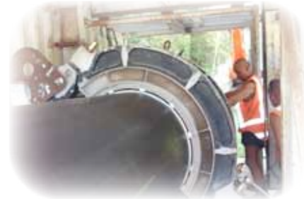
▲ Butt fusion welding of the 850 OD, SDR12 PE pipe.
