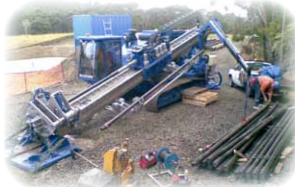
▲ Universal HDD Rig (100 ton pull back)
