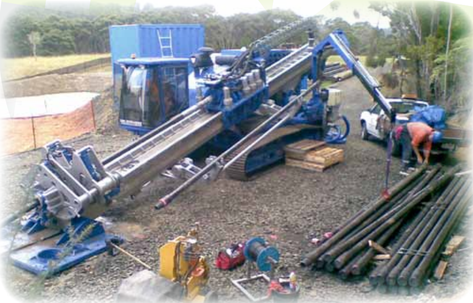
▲ Universal HDD Rig (100 ton pull back)
