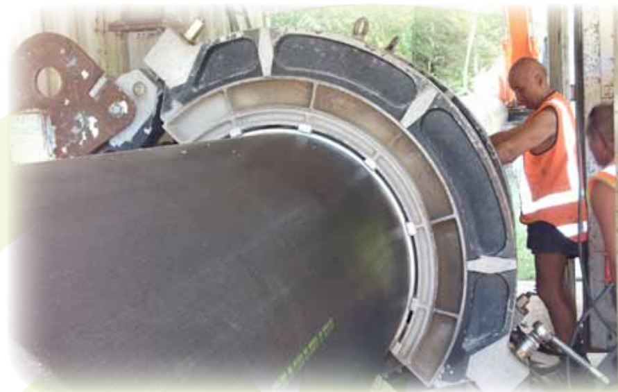
▲ Butt fusion welding of the 850 OD, SDR12 PE pipe.
